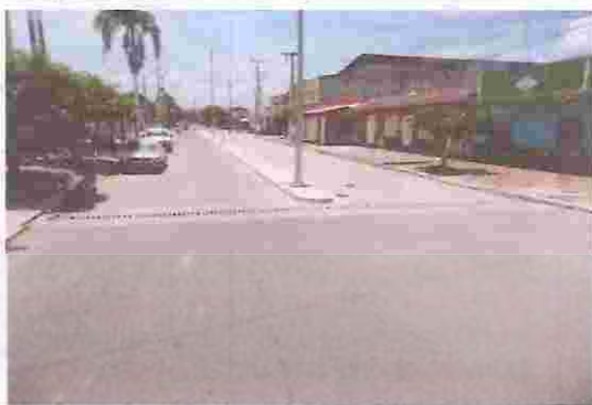
40. Pavimentos en concreto
