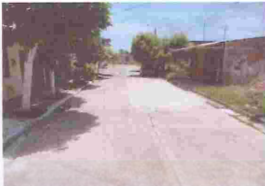
66. Vista general tramos en concreto
