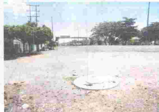
23. Intervención sobre la vía principal antigua Panamericana
