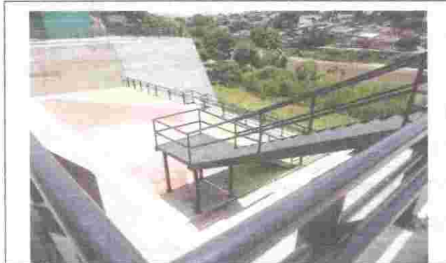
3. Barandas y escaleras metálicas
