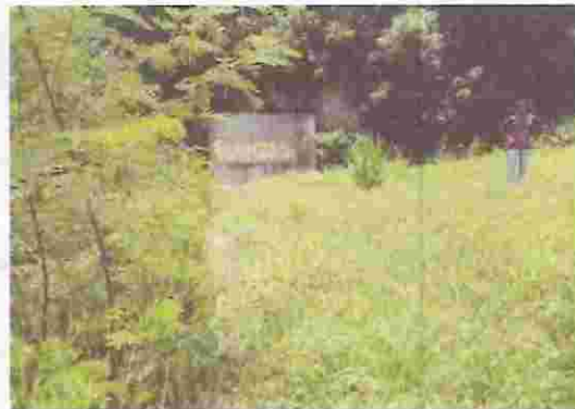
8. Muro de contención inferior
