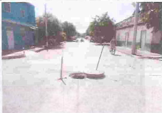
14. Destape de pozos para su inspección
