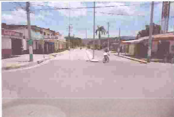
38. Pavimentos en concreto hidráulico
