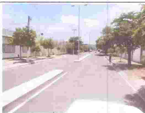
27. Separadores en concreto hidráulico
