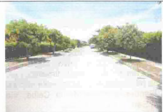
62. Vía Construida en concreto asfáltico
