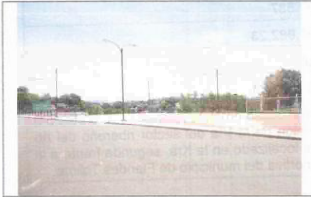
1. Vista general sobre la vía
