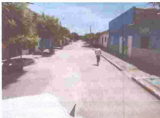
81. Reparaciones por cambio de redes
