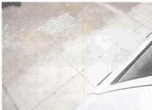
65. Reparqueo técnico adecuado en concreto
