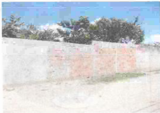
20. Actividades complementarias: Mampostería, columnas y vigas
