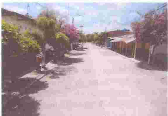
82. Reparación por cambio de tubo principal
