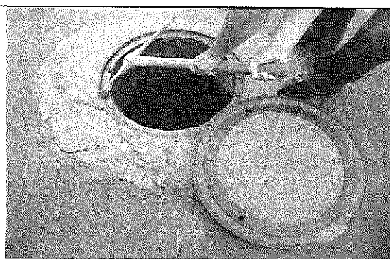
46. Destape de pozo para su revisión
