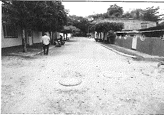
22. Inicio de Obra
