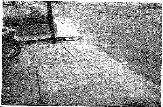
51. Cajas de inspección
