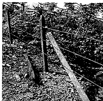
Foto 1.2 . Pie de amigo mal instalado
