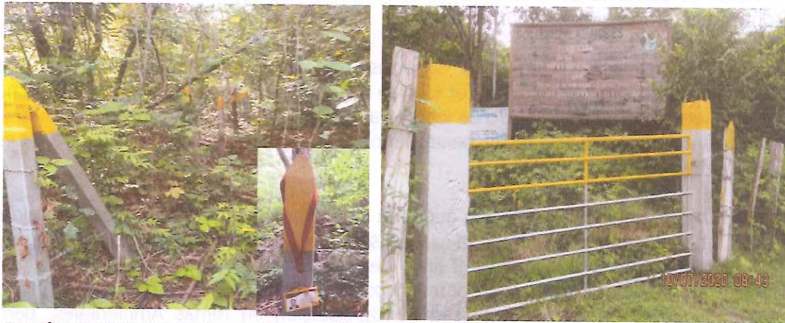
Foto N° 11. Mantenimiento a la Cerca tradicional , realizado por CORTOLIMA . Contrato N° 664 29/10/2019 CORFENIZ
