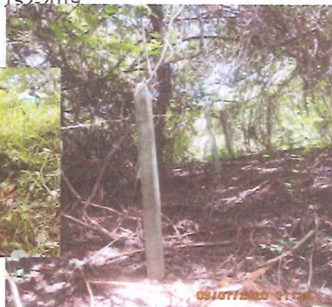
Foto N°17 . Aislamiento sin terminar ,poste abandonados
