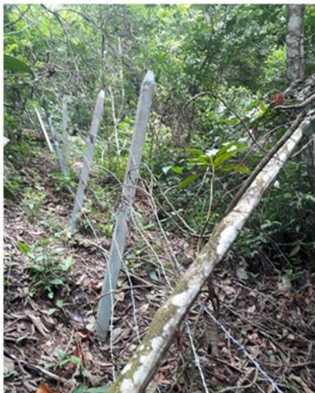
Imagen 8 Rollos de Alambre de Púa abandonados y cerca en mal estado
