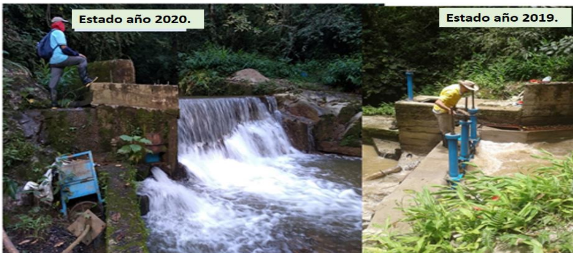
Imagen 7 Estado de la Bocatoma sobre la Quebrada el Quebradon .Acueducto Urbano Municipal
