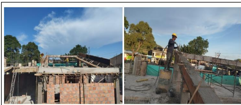
Viga perimetral a dos niveles e inclinada.
