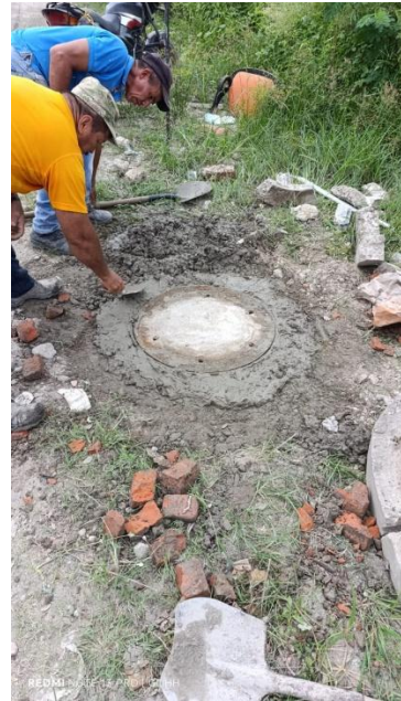
8. Re instalación de tapas encontradas en mal estado o mal instaladas
