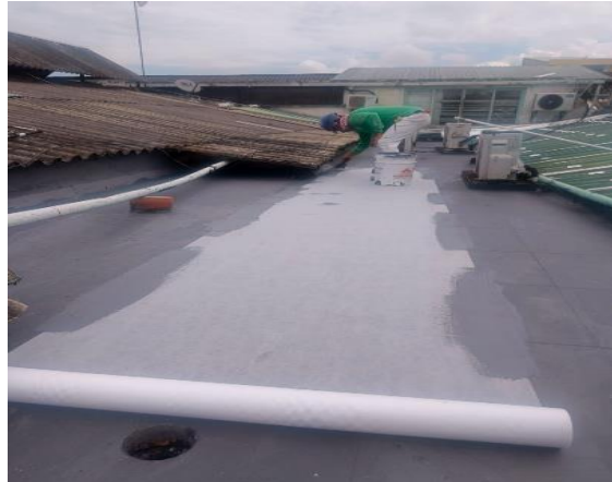
PROCESO DE IMPERMEABILIZACIÓN - INSTALACIÓN DE MEMBRANA DE IMPERMEABILIZACIÓN COMPLEMENTARIA Y BRONCO CUBIERTA
