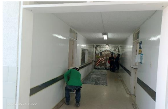
APLICACIÓN DE PINTURA SINTETICA ZONA INFERIOR
