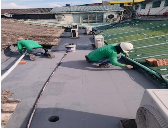
PROCESO DE IMPERMEABILIZACIÓN - INSTALACIÓN DE MEMBRANA DE IMPERMEABILIZACIÓN COMPLEMENTARIA Y BRONCO CUBIERTA
