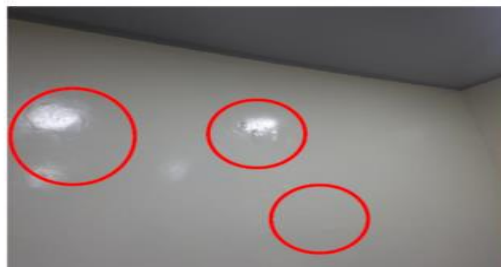
Imagen 2 Pintura embombada optometría.
