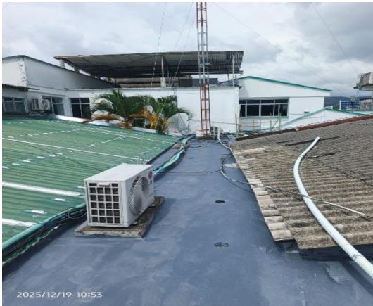
PROCESO DE IMPERMEABILIZACIÓN - INSTALACIÓN DE MEMBRANA DE IMPERMEABILIZACIÓN COMPLEMENTARIA Y BRONCO CUBIERTA
