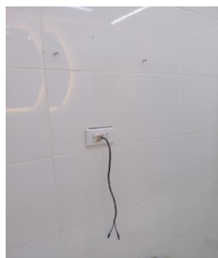
28. Instalación eléctrica de espejo flotante desprendida
