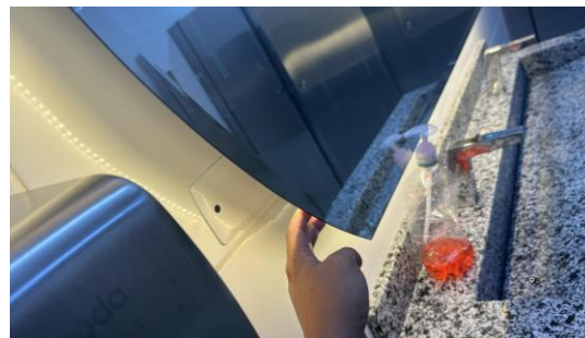
28. Instalación eléctrica de espejo flotante desprendida
