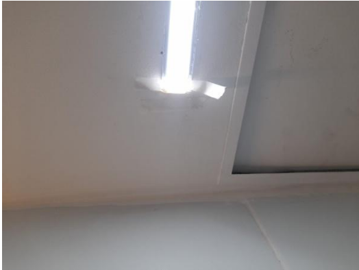
Luminaria led, aseguradas con cinta de papel
