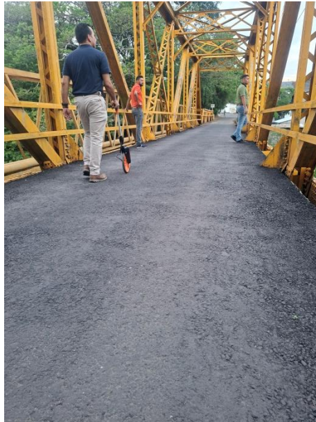
Imagen 18 Detalle de la textura superficial de la mezcla asfáltica instalada.
