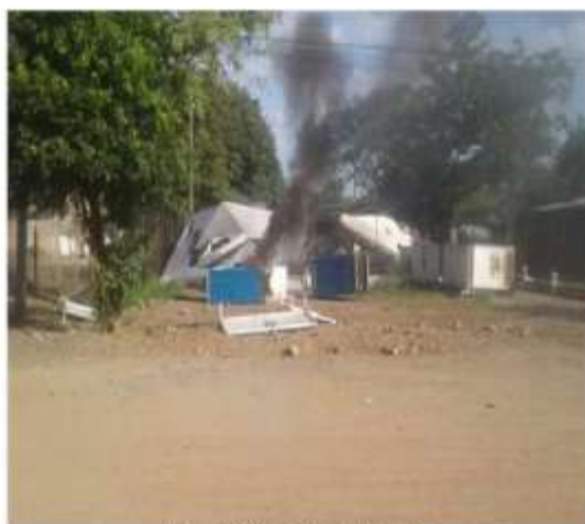
Destrucción de Baterías Secundarias incineradas
