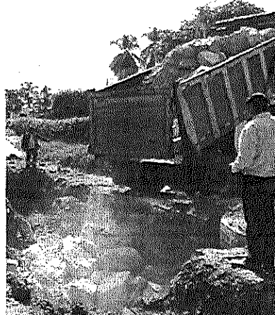
Fotografía 4. Rellenos realizados para el mejoramiento de sustrato. Se observa mejoramiento utilizando material de relleno, grava y pedraplen compacto
