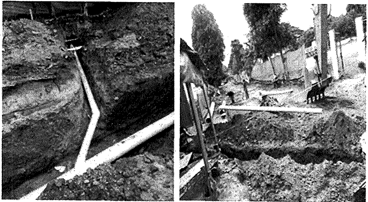
Fotografía 9. Excavaciones varias manuales para la instalación de acemietas
