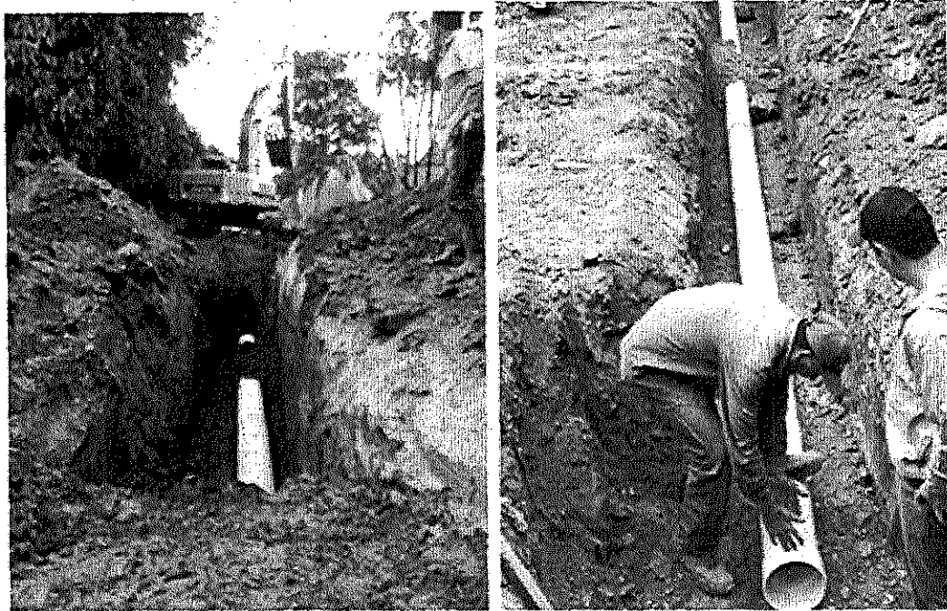
Fotografía 7. Material para atraque de tubería
