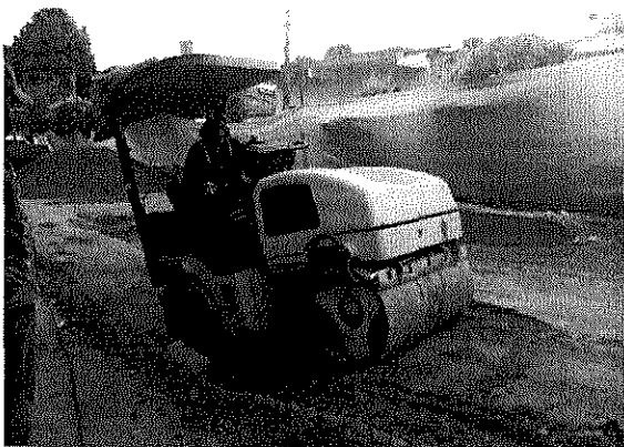
Ilustración 6. En obras de protección resultados, permite la libre circulación de maquinaria pesada para acomodar las áreas sustentadas.
