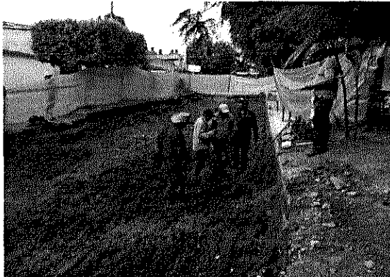
Ilustración 1. Obras de Protección Cra. 9 entre calle 5 y 6.
