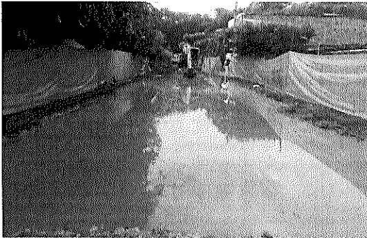
Ilustración 9. Obra de protección en carpas. Hechos en medio de agua presentada en la vía debido a lluvias puntuales en el momento de realizar las excavaciones
