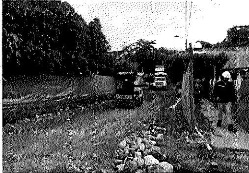
Ilustración 8. Cerca verde instalada en el sector, una vez mejoró la zona adecuada a las condiciones de intervención en el
