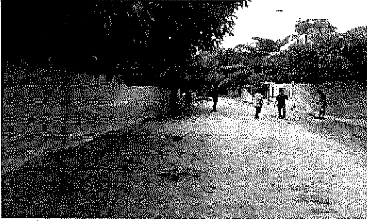
Ilustración 7. Instalación de cerca de protección, C/3 entre calles 9 y 10
