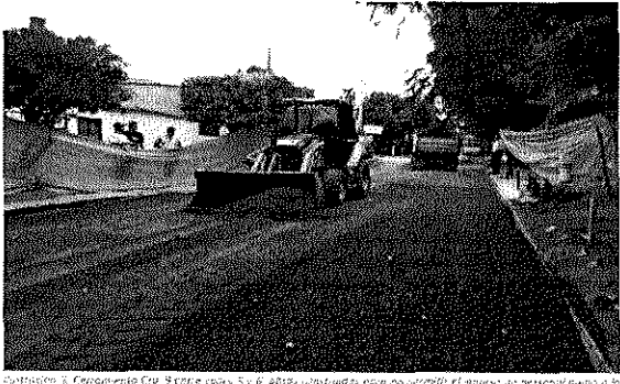
Ilustración 5. Cercamiento Cra. 9 entre calles 5 y 6, áreas sustituidas para no permitir el ingreso de personal externo a la zona además de suministrar agua potable y electricidad
