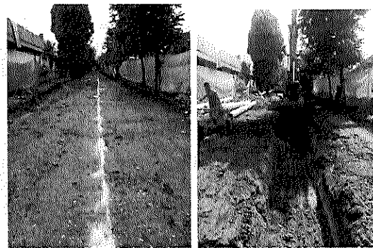
Ilustración 12. Obras de protección instaladas para la intervención de obras de construcción, confirmación de la
