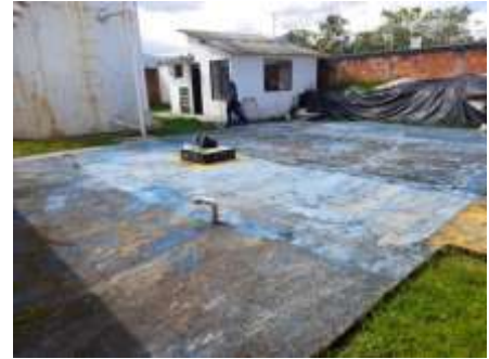
2. Zona de aplicación de pintura epóxica con su alistamiento
