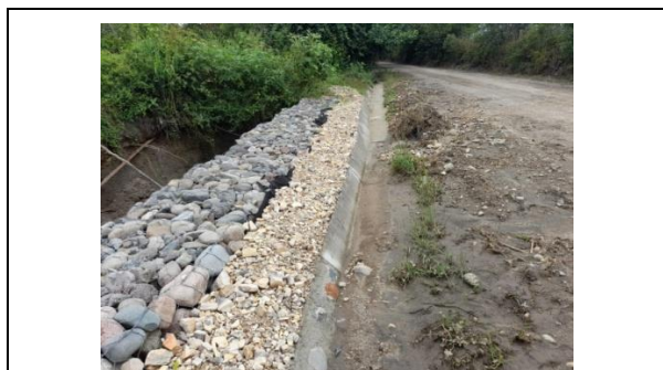
7. Vista superior del muro en gavión
