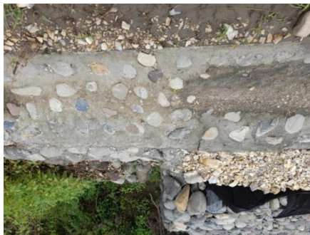
9. Detalle de cuneta
