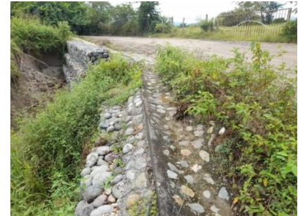
8. Vista de cuneta superior
