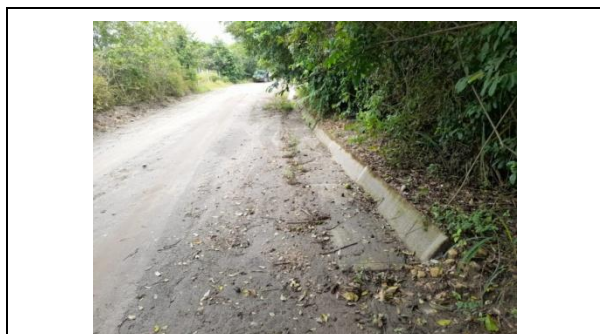
5. Inicio de cuneta en concreto sobre la calzada
