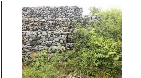
3. Inicio de la obra
