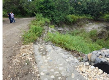
6. Vista superior con cuneta
