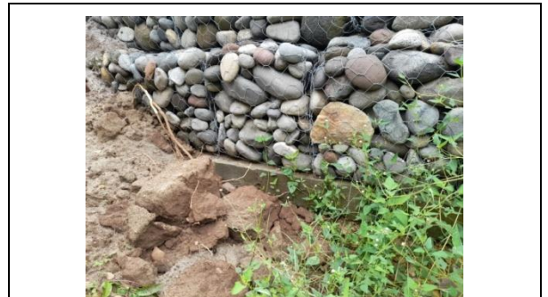
4. Detalle en la cimentación
