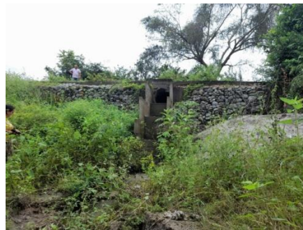
10. Vista general de la obra
