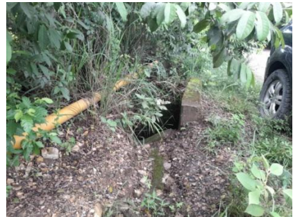
7. Cuneta sobre calzada
