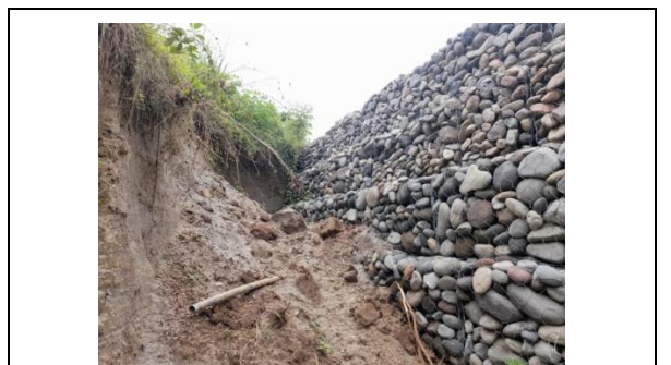
8. Inicio de obra
