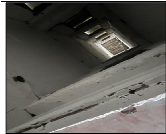
pintura, resane e impermeabilizado foso ascensores altura 20 MTS
