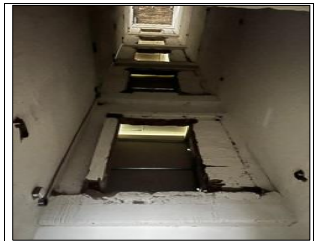
Muro divisorio entre ascensores (superboard)
