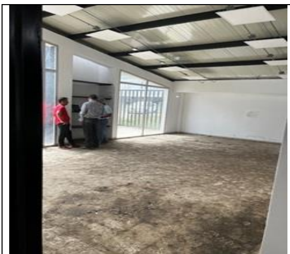
Muro con pañete y pintura, cubierta tipo sándwich correa tubo rectangular
