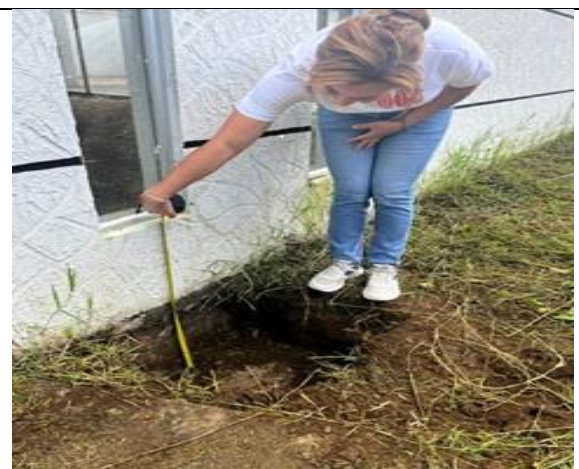
Nivel de cimentación Bloque B
