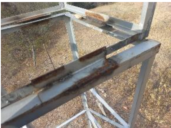
Estructura metálica con oxidación y desplazamiento Fuente: Visita in situ – Equipo auditor
