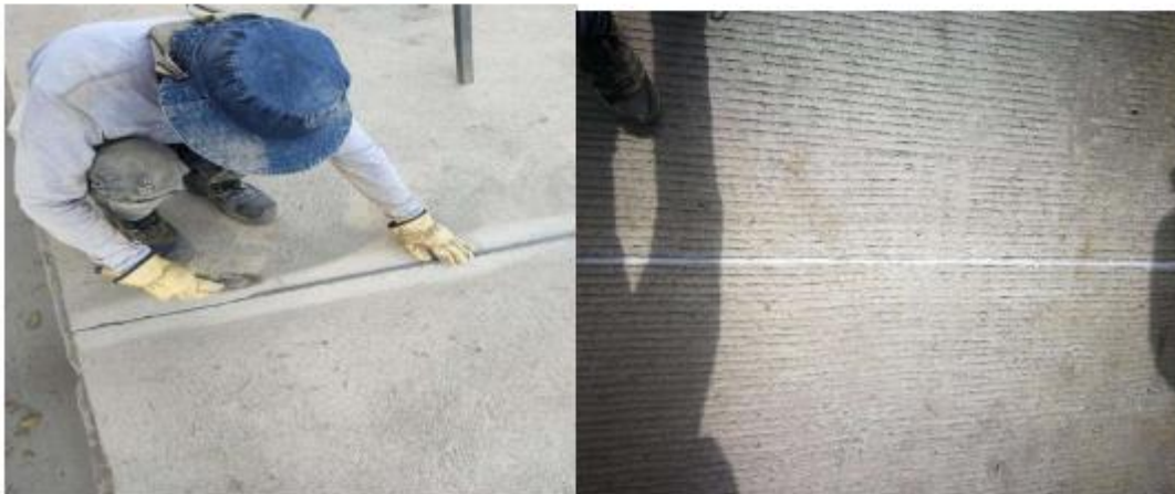
Actividades ejecutadas en cada una de las vías intervenidas.
