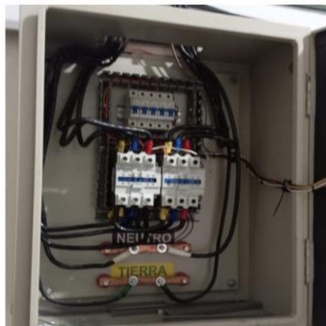
ESTADO ACTUAL DE LA TRANSFERENCIA
