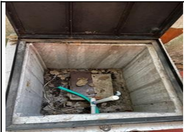
1. Instalación motobomba "la chamba"
