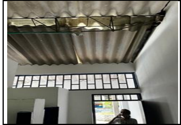
4. Reparación de techo para cubierta de baño
