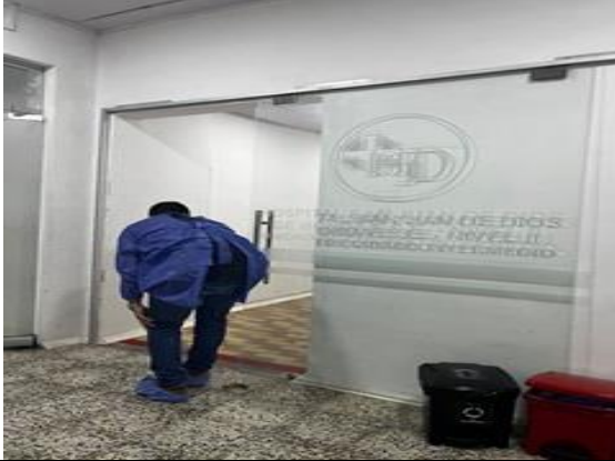
Puerta corredera con marco de aluminio 3x1 hoja en aluminio ref. 1102 y vidrio tipo hielo de 4 mm.
