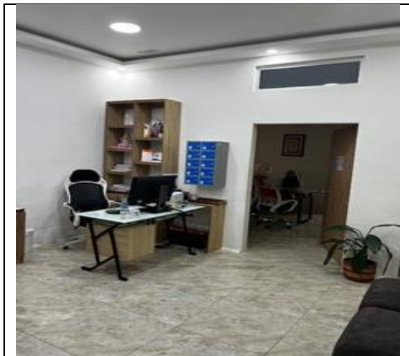
13.2- suministro e instalación de piso cerámico 45x45 Cm. Tipo ALFA o similar
