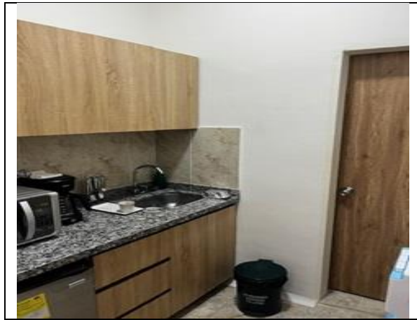
15.2-Suministro e instalación de mueble bajo mesón en formica de color
