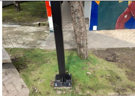
59. Dados en concreto para cimentación
