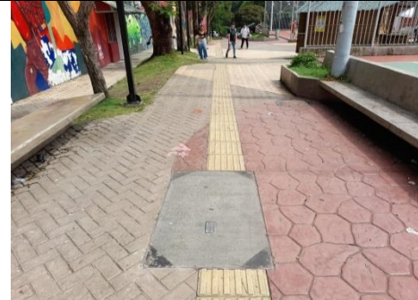
57. Cajas de inspección eléctricas y datos
