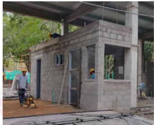
Fotografía 6: Zona de la portería principal en la cual se ejecutó la placa de entrepiso en concreto 3.500psi
