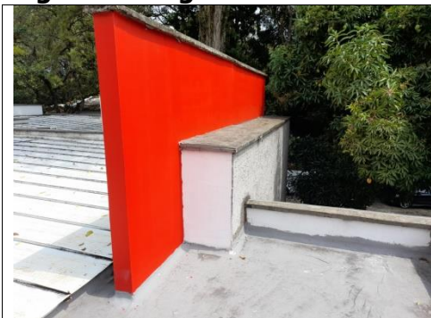
14. Mampostería con aislamiento térmico
