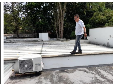
16. Revisión de cubierta
