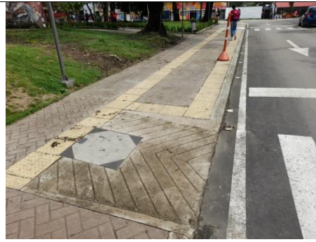
65. Rampas para movilidad reducida
