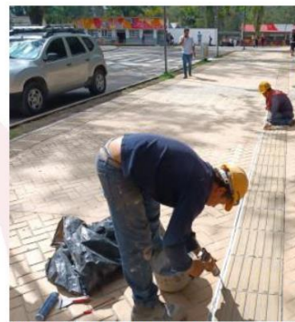
Fotografía 2: Instalación de sellado de dilataciones
