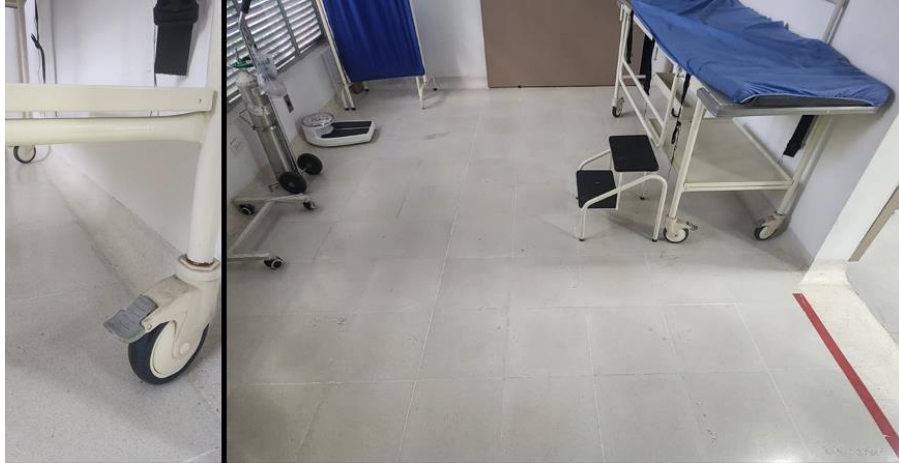
Imagen 1: sala de procedimientos piso y mediacaña en buenas condiciones.
