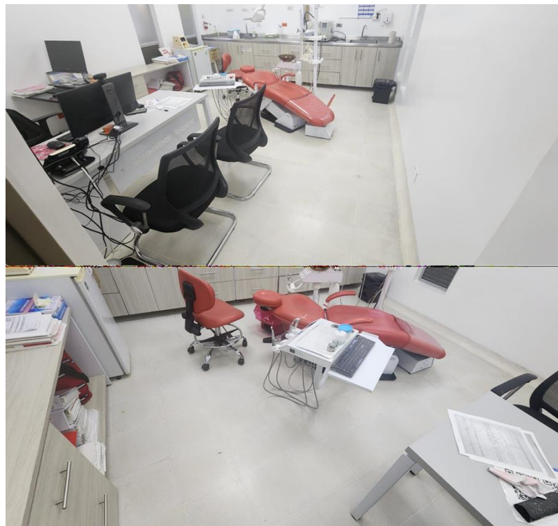
Imagen 4: Mediacañas y piso en buenas condiciones, área de consultorio odontológico.
