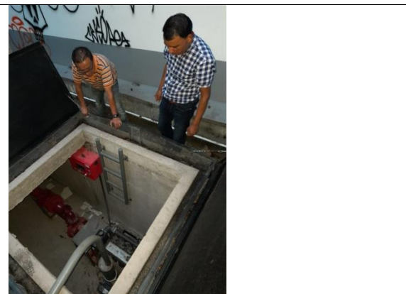
33. Acceso a cuartos de máquinas. Compañía del contratista y supervisión
