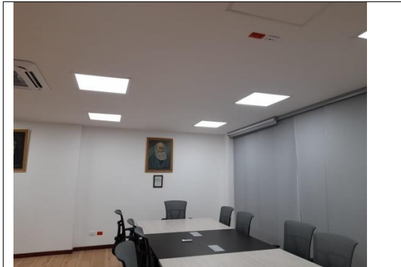
25. Cielo raso en dry wall
