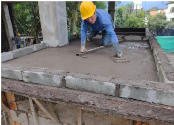
Fotografía 5: Construcción de la placa de entrepiso en concreto 3.500psi
