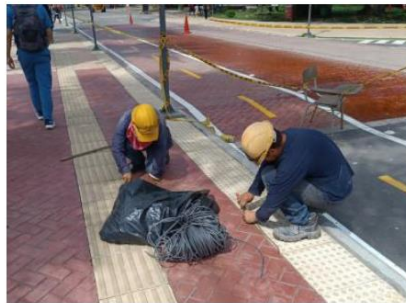
Fotografía 1: Instalación de sellado de dilataciones
