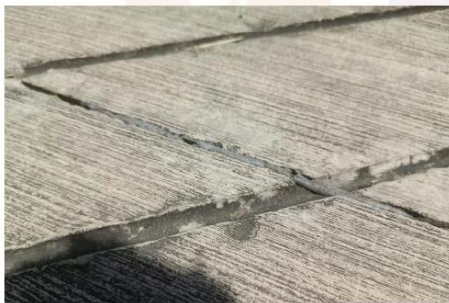
Fotografía 4: Nuevo Sello de dilatación instalado
