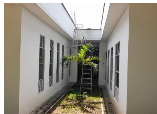
21. Acceso a la cubierta
