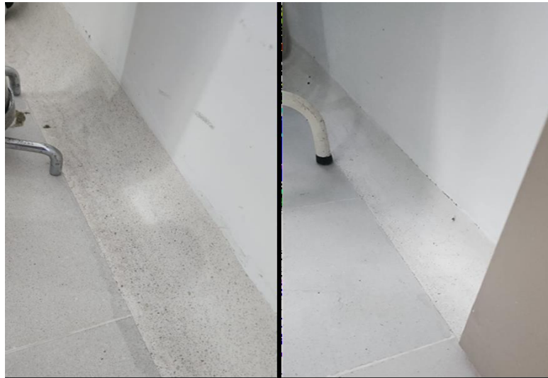
Imagen 2: Mediacañas en buenas condiciones, área de procedimientos y consultorio odontológico.
