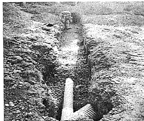
En la imagen No.3 y No. 4, se observa el proceso de instalación de tubería de aguas negras.
