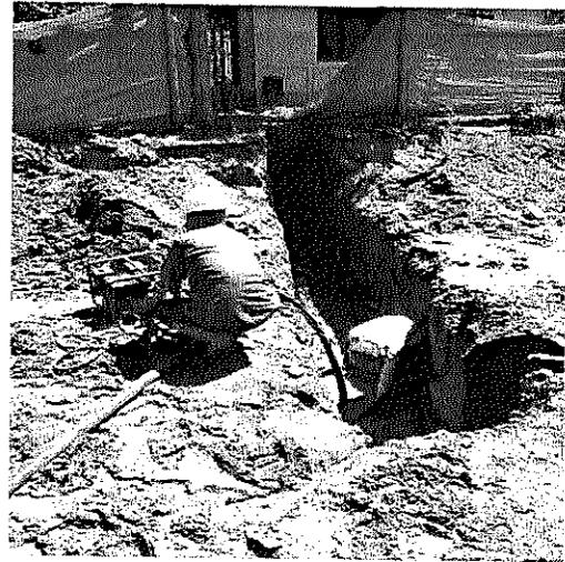
En la imagen No.20 y No. 218 , se observa el retiro de aguas negras por medio de motobombas debido que la tubería existen se encontraba fisurada.
