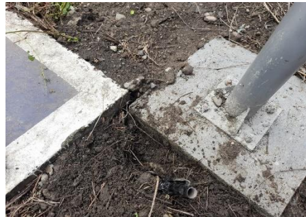
67. Verificación dados en concreto
