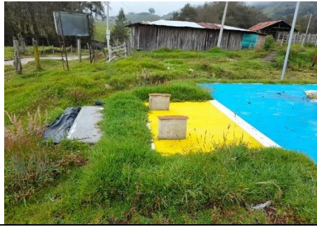
58. Elementos sin terminar y sin cumplir con especificaciones técnicas
