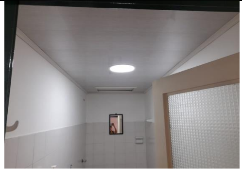
19. Mejoramiento en baño
