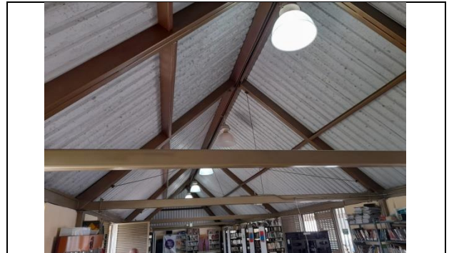
13. Punto eléctrico que no funciona
