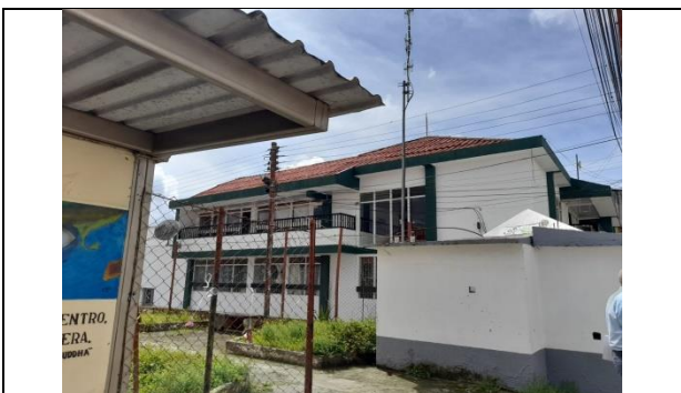
16. Mejoramiento de cubierta en alcaldía
