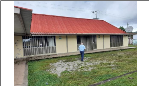
12. Vista general de la Obra, compañía del contratista
