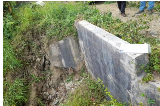
50. Muro de descole
