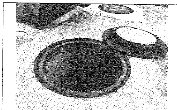
6. Tapas de alcantarillado
