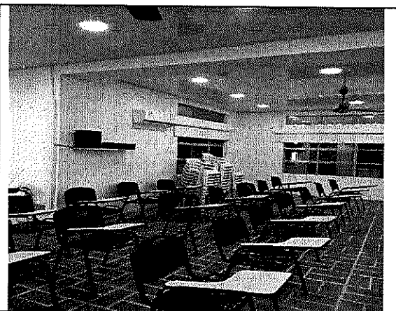
Mantenimiento de carpintería metálica, estuco y pintura
