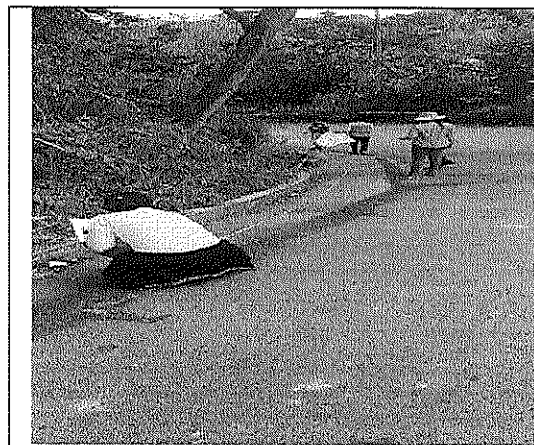
6. Cunetas concreto clase D y pavimento.
