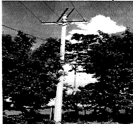
Como se puede observar, la red de media tensión se encuentra en un 85% de ejecución como se mencionó anteriormente.
