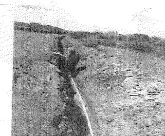
**Descripción:** Suministro e instalación de tubería de 3/4" RDE 21 línea de distribución en los tramos plasmados de los planos de diseño, **Ubicación:** Vereda Chicalá.
