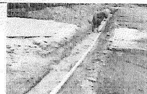
*8-Suministro e instalación de tubería de 2" RDE 26, línea de distribución*
