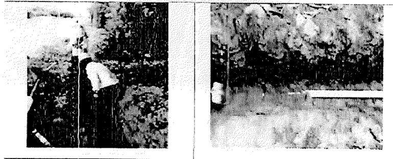
**Descripción:** Suministro e instalación de arena para cuidar la tubería y para el atraque de dicha tubería. **Ubicación:** Vereda Chicalá y Manga de los Rodríguez Municipio de Piedras Tolima
