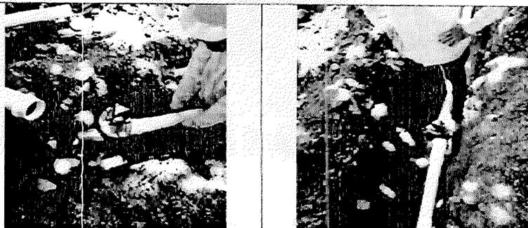
**Descripción:** Suministro e instalación de válvulas de flujo de agua en bola pvc de 3" instaladas en los sitios plasmados por los planos de diseño, en total 3" instaladas en los sitios plasmados por los planos de diseño, en total 3 válvulas,
