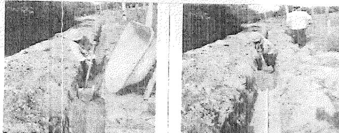
**Descripción:** Suministro e instalación de arena para cuidar la tubería y para el atraque de dicha tubería. **Ubicación:** Vereda Chicalá y Manga de los Rodríguez Municipio de Piedras Tolima
