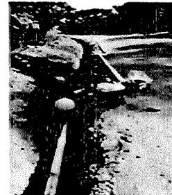
**Descripción:** Suministro e instalación de tubería de 2 1/2" RDE 26, línea de distribución en los tramos plasmados de los planos de diseño, **Ubicación:** Vereda Chicalá del Municipio de Piedras Tolima
