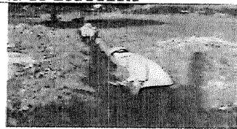
*4-Excavación manual para tubería de acueducto res de acometidas domiciliarías, excavación red a acueducto principal.*
