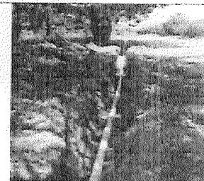
*7-Suministro e instalación de tubería de 2 1/2" RDE 26, línea de distribución.*
