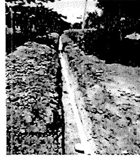
**Descripción:** Suministro e instalación de tubería de 3" RDE 32.55 línea de distribución en los tramos plasmados de los planos de diseño, **Ubicación:** Vereda Chicalá de Piedras Tolima
