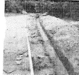
*11- Suministro e instalación de tubería de 1" RDE 21, línea de distribución.*
