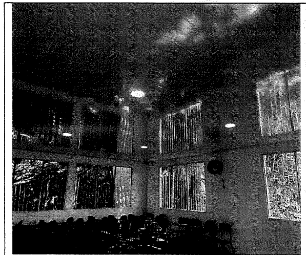
3. Instalación de cielo raso
