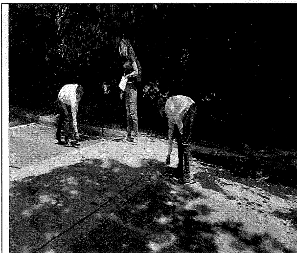
2. Reductora velocidad concreto premezclado 4.000 psi
