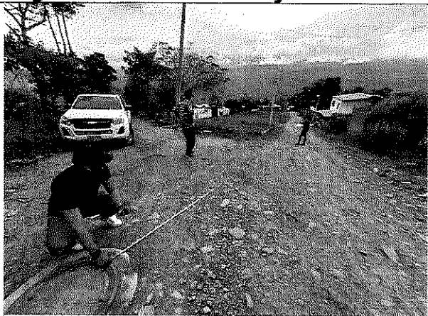
1. VERIFICACIÓN LONGITUD TUBERIA 10"
