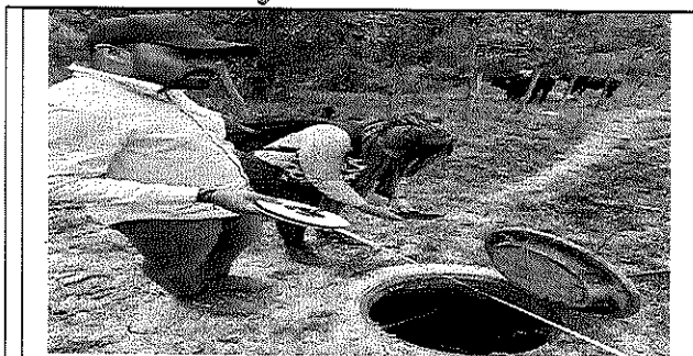
4. VERIFICACIÓN CONO Y CILINDRO DEL POZO
