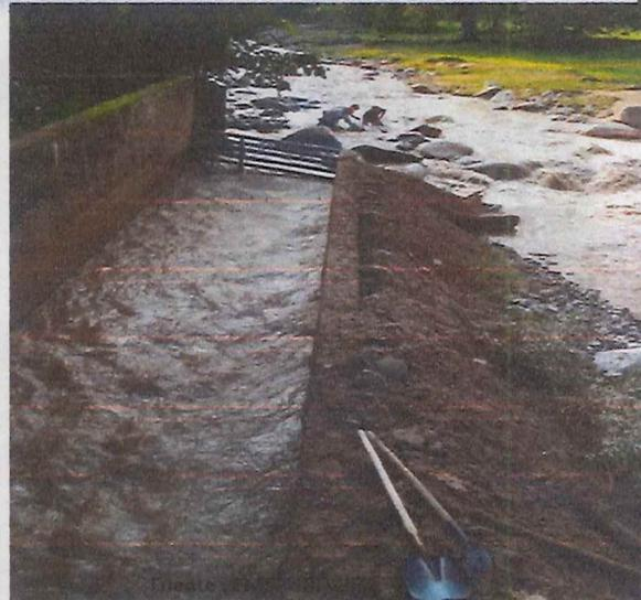
Foto: Mantenimiento manual de la bocatoma por EMSPUROVIRA.
