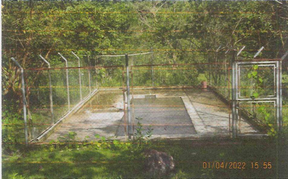
Foto. Desarenador en buen estado con cerramiento perimetral , para su protección y control EMSPUROVIRA.
