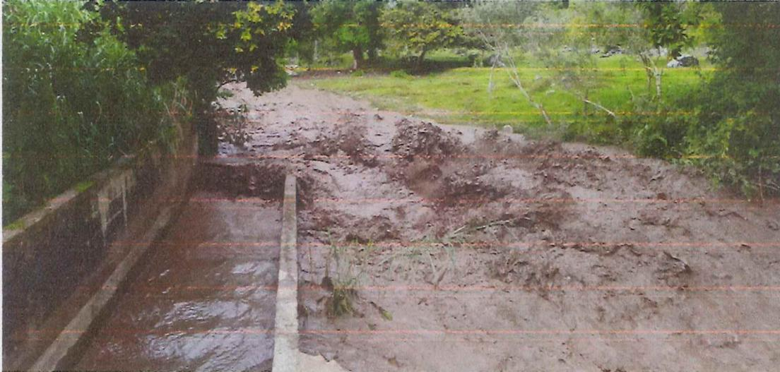
Foto . Bocatoma EMSPUROVIRA colapsada por la carga de sedimentos que aportó el Rio Luisa al sistema de acueducto , Marzo 2022. Fuente : CDT
