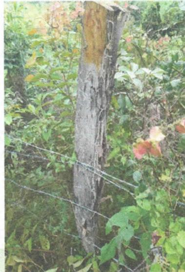
Cerca en poste de madera de eucalipto aserrada 2 ,3 y 4 caras , inmunizada en la punta con brea y 4 hilos de alambre con un % de postes en mal estado, quebrados, podridos , comején y no funcionales .ver cuadro.
