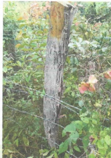
**Cerca en poste de madera de eucaliptus aserrada 2 ,3 y 4 caras , inmunizada en la punta con brea y 4 hilos de alambre con un % de postes en mal estado, quebrados, podridos , comején y no funcionales .ver cuadro.**
