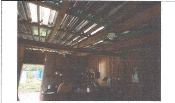
90. Interior de Vivienda
