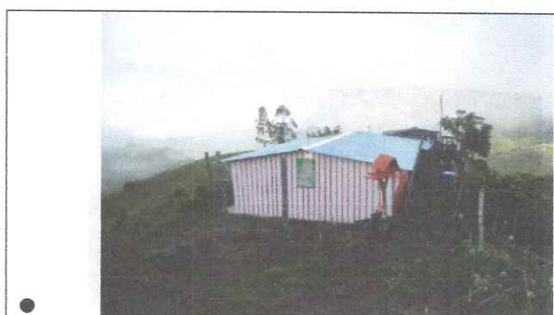
37. Cubierta en teja Arquitectónica
