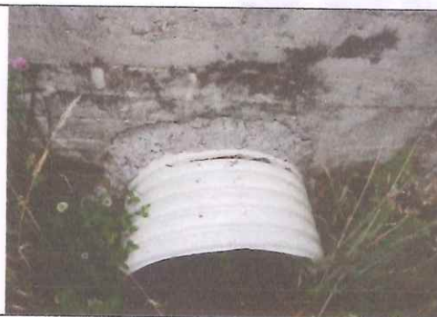
15. Tubo plástico instalado
