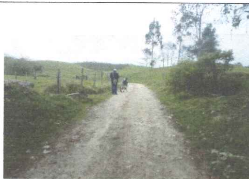
8. Zona de instalación bajo vía veredal
