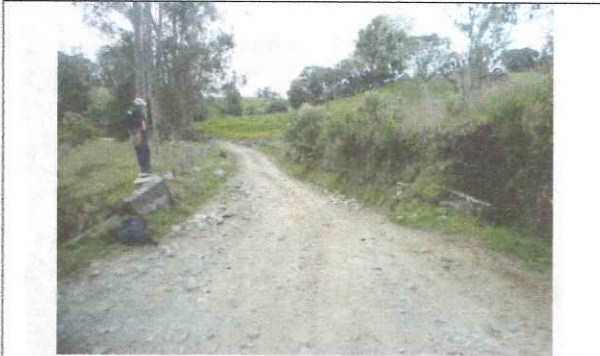
16. Zona de instalación del tubo
