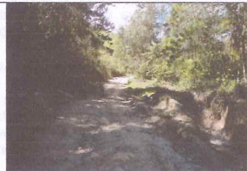
3. Vista general, sitio del tubo de 36" introducido
