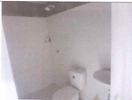
77. Interior unidad sanitaria
