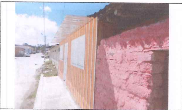
98. Cubierta en teja Arquitectónica
