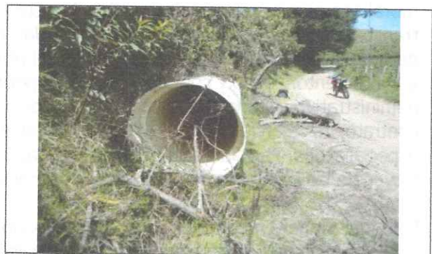
8. Tubos plásticos doble pared corrugados
