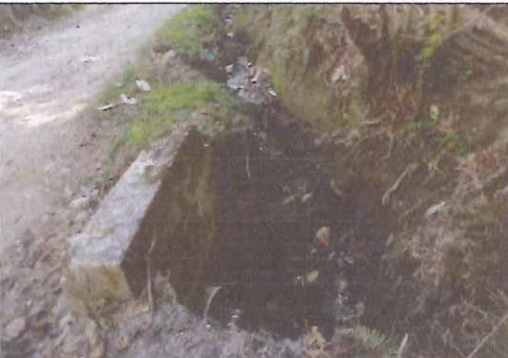
0. Extremo del tubo introducido bajo la vía
