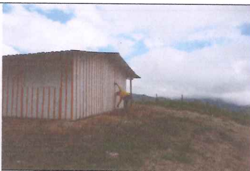
31. Fachada lateral y mediciones en campo
