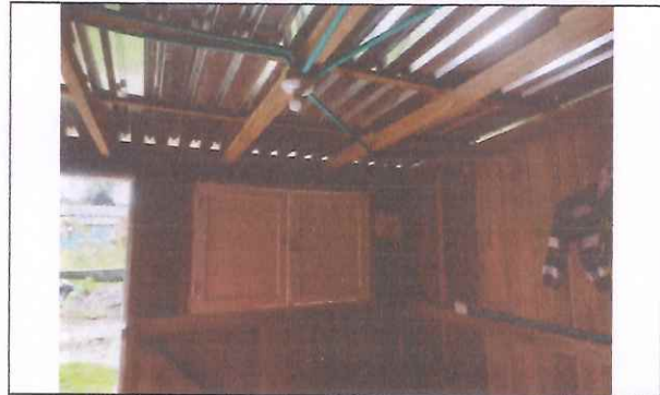
86. Interior de Vivienda
