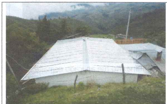
10. Cubierta en teja Arquitectónica
