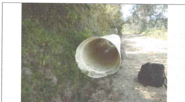
Tubos que no prestan ningún servicio
