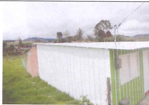
63. Cubierta en teja Arquitectónica
