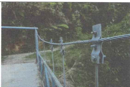
7. Abrazadera metálica superior, barras circulares y cable
