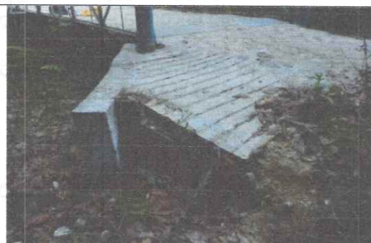
4. Rampa de aproximación
