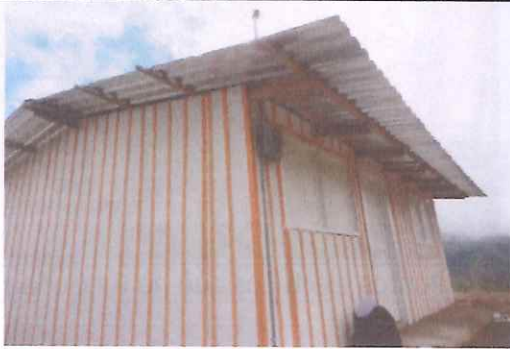
15. Cubierta en teja Arquitectónica
