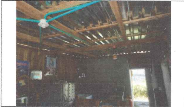
101. Interior de Vivienda
