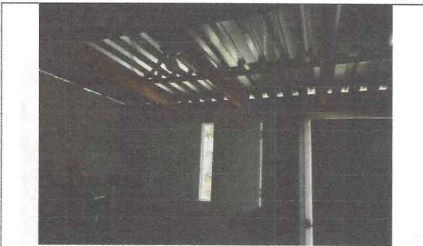
70. Interior de Vivienda
