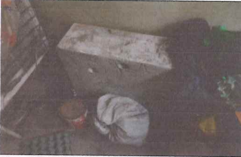
3. Pintura esmalte y lavadero sin instalar
