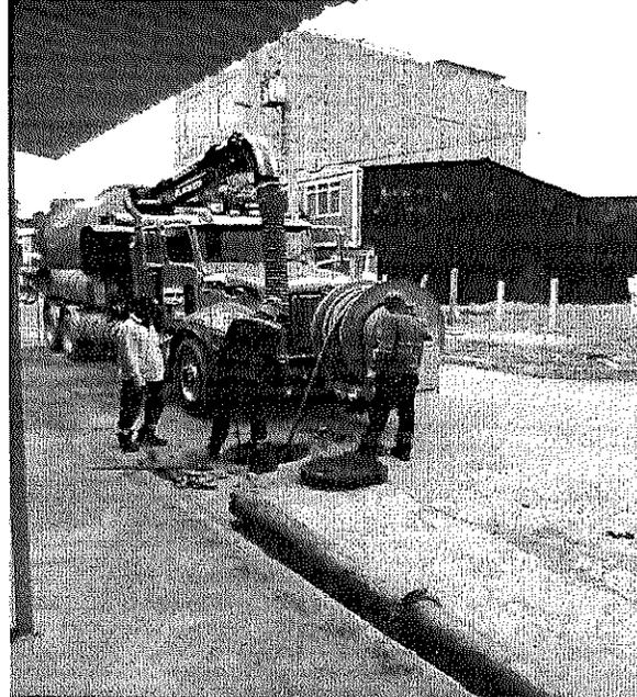
Fotos: Vector prestando el servicio de despanamiento de redes de alcantarillado
