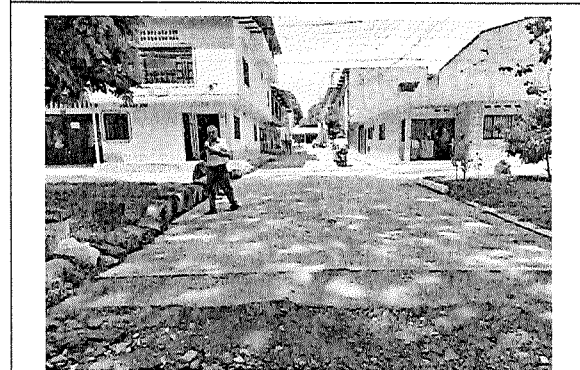
36. extremo de pavimento
