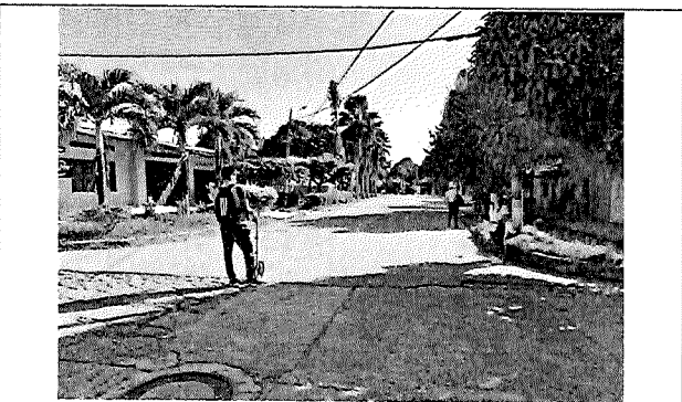
11. inicio de la pavimentación
