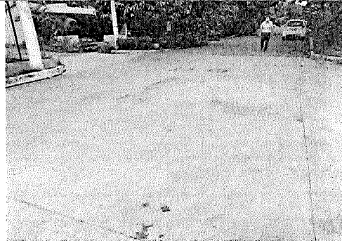
4. intersección de las vías intervenidas
