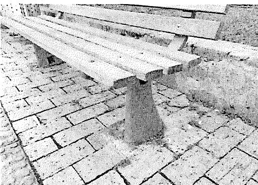
79. apoyo en concreto de banca
