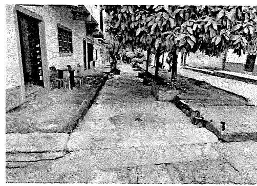
61. extremo de pavimento
