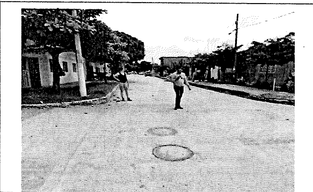
10. fin de la intervención
