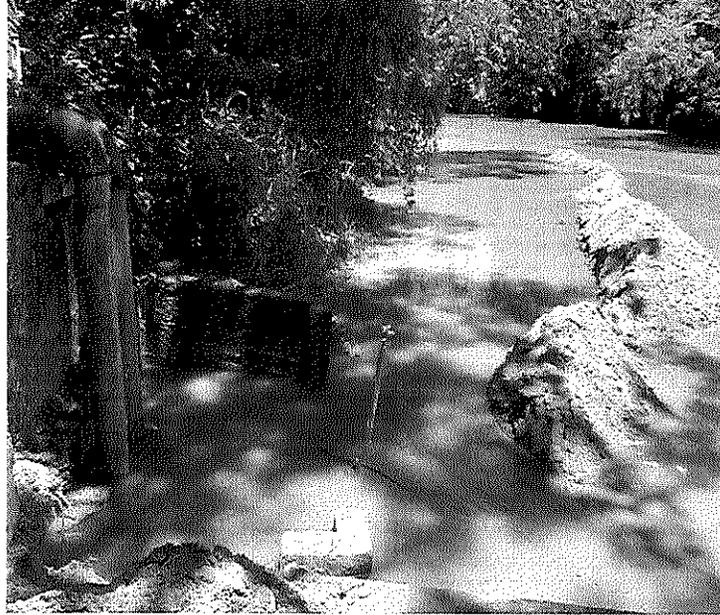
Infraestructura de la Bocatoma funcional agosto 2021 captación de agua , con permanente problema de sedimentación
